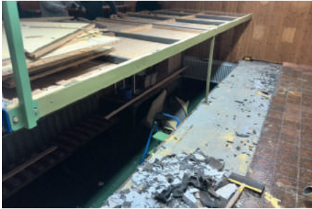
Rückbau der alten Seilzug-Stände
