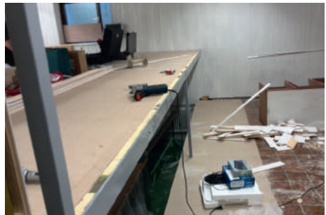
Wiederaufbau der Schützenstände
