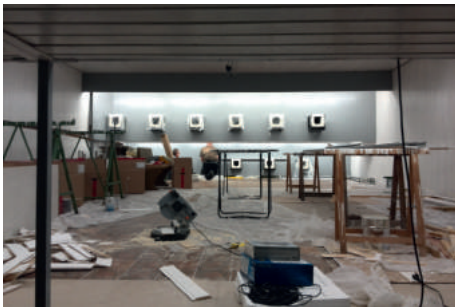
Montage der neuen elektronischen Messrahmen
